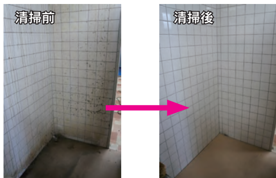
1階共有キッチン壁
